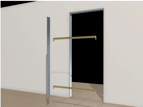
1. Extraer los distanciadores y la tapeta lateral. Remove the spacers and side cover. Extraire les séparateurs et le cache latéral.
